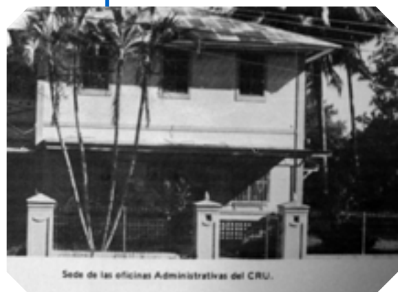
El Centro Escolar Antonio José de Sucre fue escogido para albergar a la progresiva población universitaria. El CRU, mientras se construían edificios propios.
