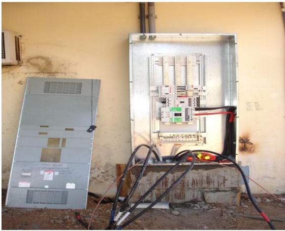
Fig. 2: Panel de Distribución de las Cargas
