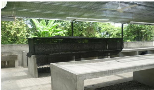
Fig. 6: Remodelación del Invernadero I Etapa
