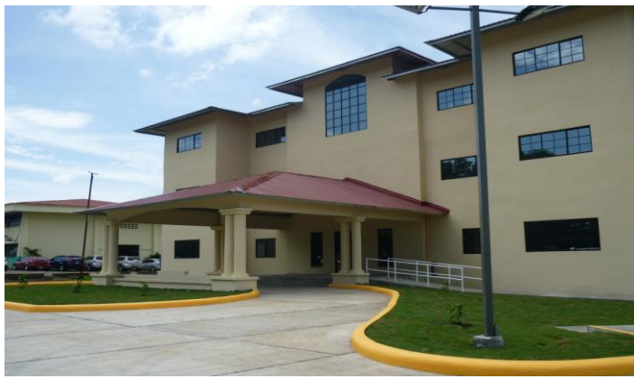
Fig. 1: Vista del Edificio de Oficinas Administrativas
