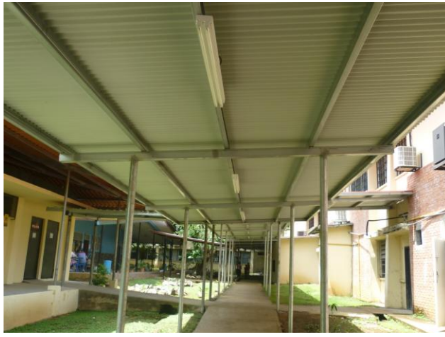
Fig. 18. Pasillo de Ceiqui
