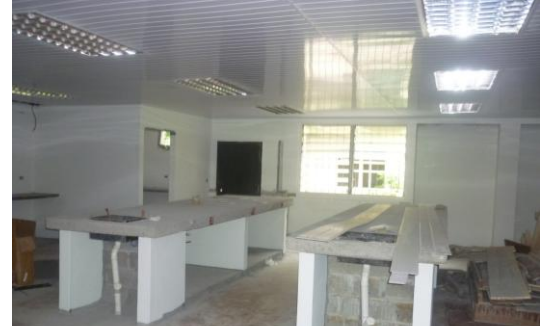
Fig. 4: Ampliación de Laboratorio de química Analítica
