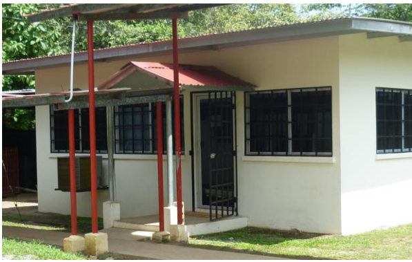
Fig. 15-a: Remodelación del Departamento de Arquitectura
