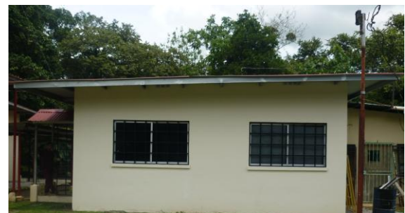
Fig. 15-b: Remodelación del Departamento de Arquitectura
