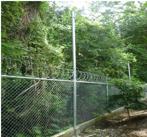
Fig. 17. Construcción de Cerca y acera perimetral de Fac. de Ciencias
