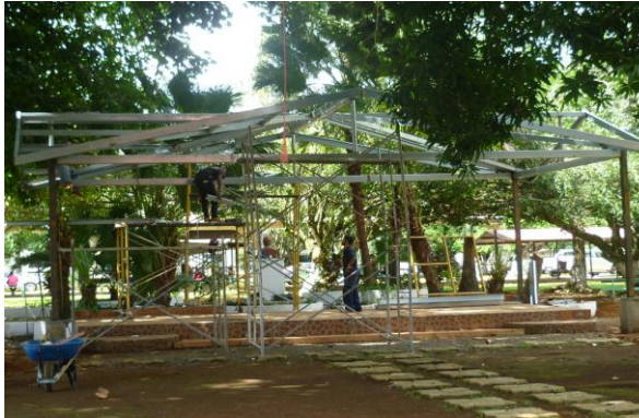
Fig. 9: Construcción de techo del Parque Andrés Bello
