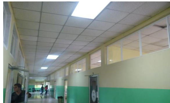
Fig. 10-b: Cambio de ventanas para el Edificio de 4 Plantas
